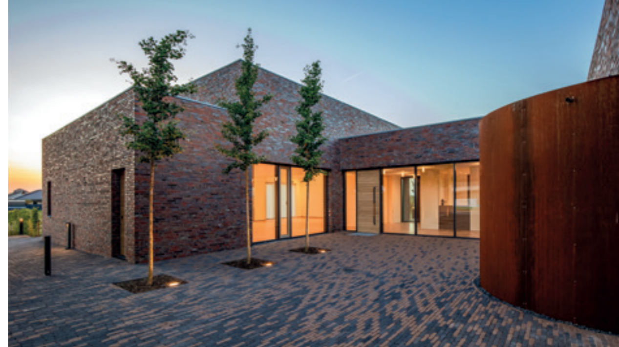
Atrium und Pfarrsaal
