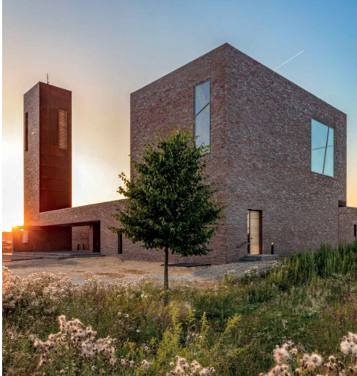
Blick von Südosten auf Kapelle und Turm
